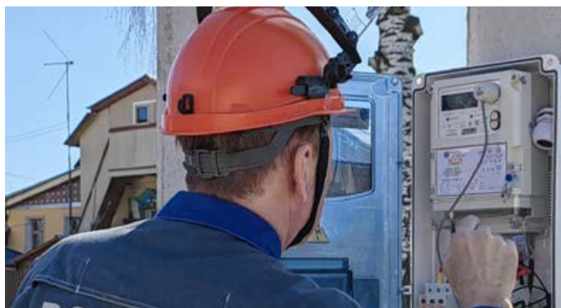
Специалисты «Россети Центр и Приволжье» – «Ивэнгерго» продолжают работы по оснащению региона интеллектуальными приборами учета электроэнергии. До конца года планируется установить более 3500 «умных» счетчиков.
